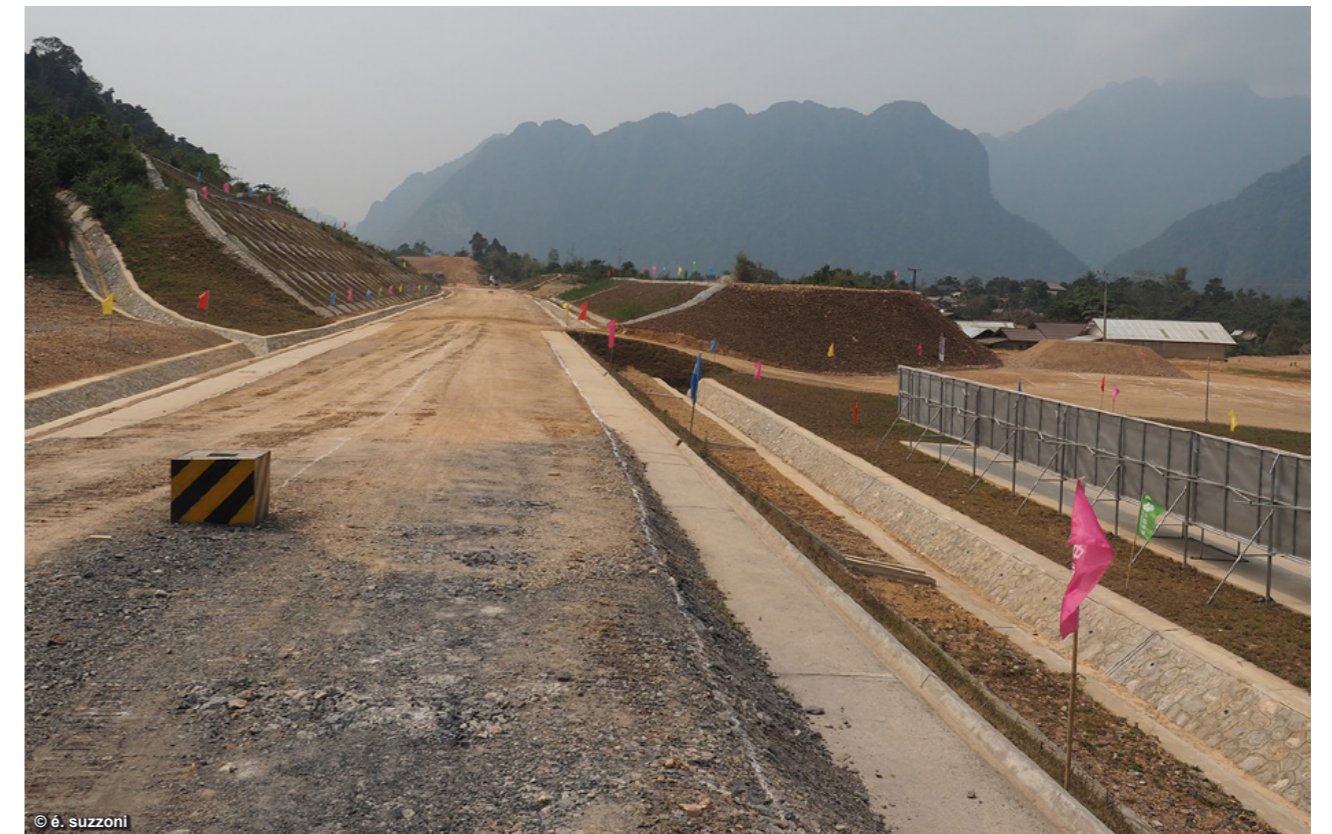
construction de la ligne "TGV" Vientiane - Boten, ici au Nord de Vang Vieng (inaugurée le 03/12/2021)
